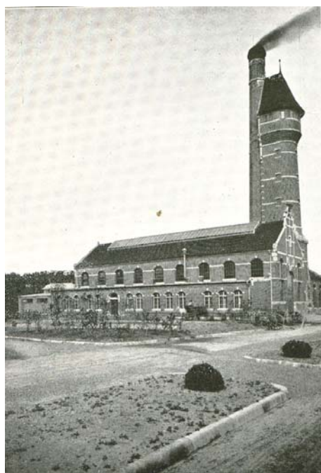
Budynek Laboratorium Maszynowego
