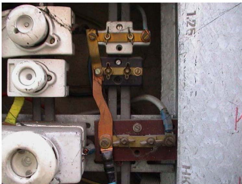
Bild 1: Verteiler mit Neutraleiterklemme mit Flügelmuttern
